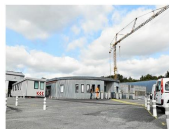
La CCPBS va profiter de la modernisation du centre technique communautaire pour installer une centrale photovoltaïque sur les toits. Un projet porté par la centrale villageoise de l'Ouest Cornouaille. (Le Télégramme/Déphine Tanjou)
