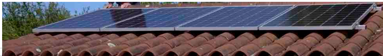
Cas-type n°3 : chauffe-eau électrique, tarif nuit
