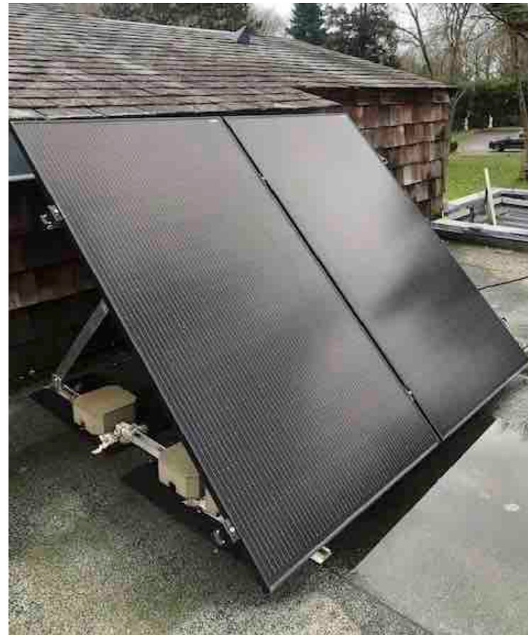
Lest sur protection de toit bitumé
