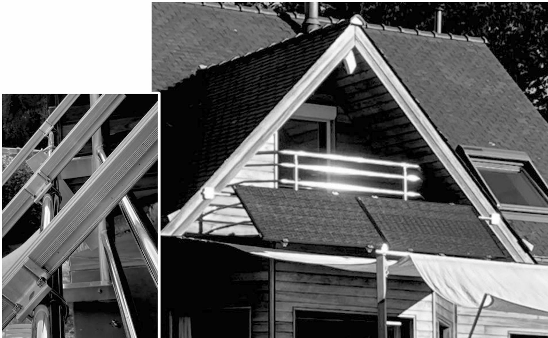
*Quelques fixations en sus, inclinaison modifiable à 45° ou 60°*
